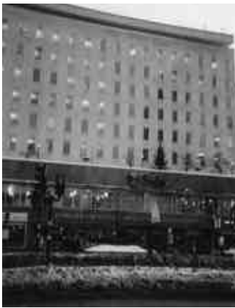
Sida本部 中央右側にシンボルマークと Sidaの文字が見える 写真1
